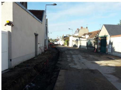
Situé à l'est de la ville d'Orléans, les travaux de réseaux et d'aménagement ont duré 8 mois. Ils ont consisté en l'enfouissement et le remplacement de nombreux réseaux, ainsi que l'aménagement des trottoirs (bordures, pavés, enrobés et béton désactivé) et la réfection de la voirie.
